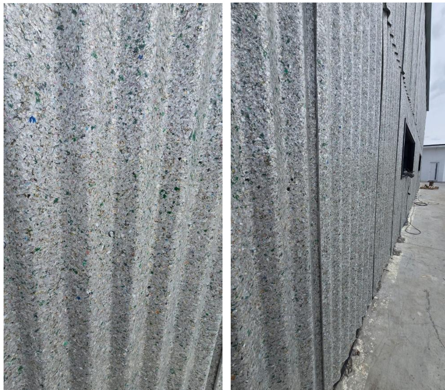
Figura 10: Chapa bioclimática utilizada en la construcción del Ecopunto
