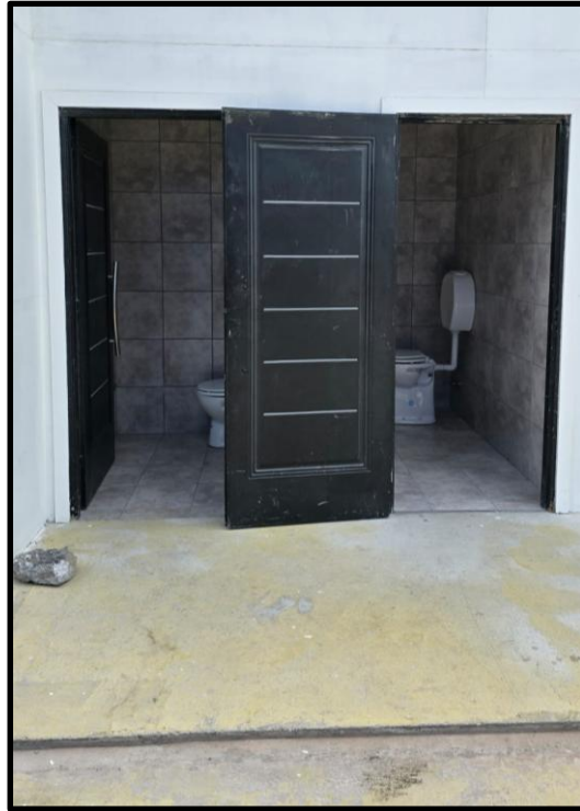
Figura 5: Sanitarios en construcción.
