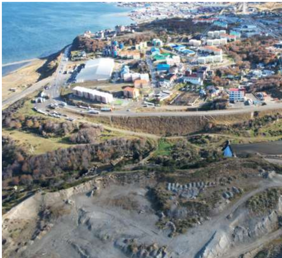
Imagen 26 - Vista aérea del recorrido de la traza de tendido eléctrico desde el sitio principal hacia la central actual (fuente imagen propia)
