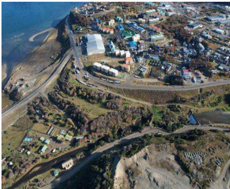
Imagen 49 - Vista aérea del barrio 640 viviendas en la parte superior, el sitio principal en la parte inferior, a la izquierda Estación Piscicultura "Río Olivia". Fotografía tomada el 18.4.2023 (Ubicación de toma fotográfica 54°47'45''S-68°13'25''O - Altitud 465 mts.)
