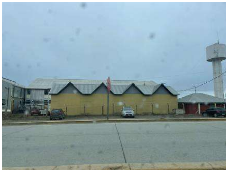
Imagen 9 - Central termoeléctrica actual de Ushuaia
