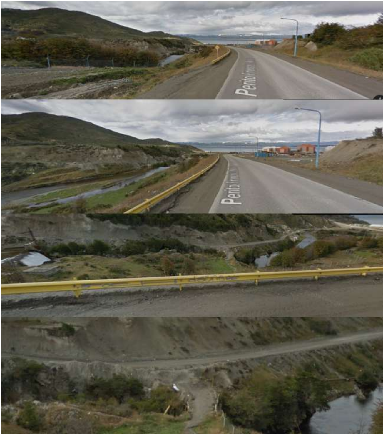
Imagen 26 - Secuencia de imágenes a nivel suelo de la traza del gasoducto desde la Rotonda Ruta 3, hasta el sitio principal (fuente Google Maps).
