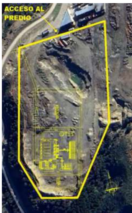
Imagen 1: Ubicación propuesta para el emplazamiento de la nueva Central Termoeléctrica.
