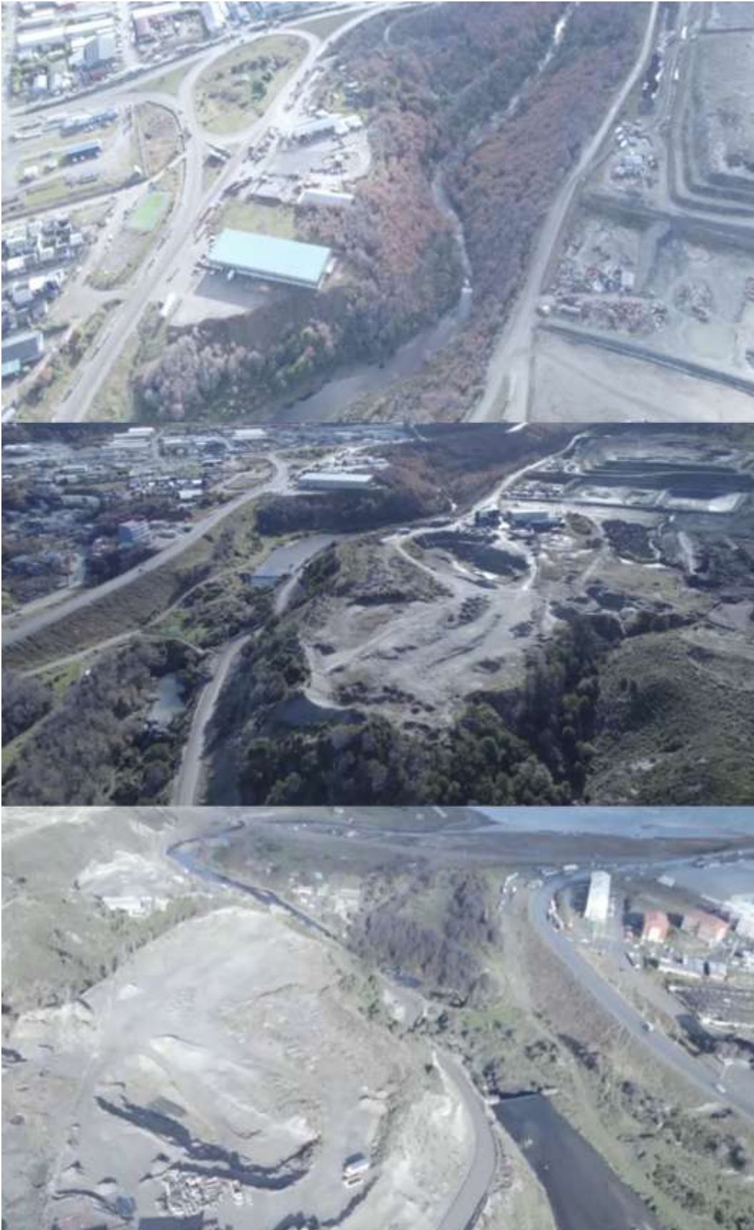
Imagen 24 - Secuencia de imágenes aéreas de la traza del gasoducto desde la Rotonda Ruta 3, hasta el sitio principal.
