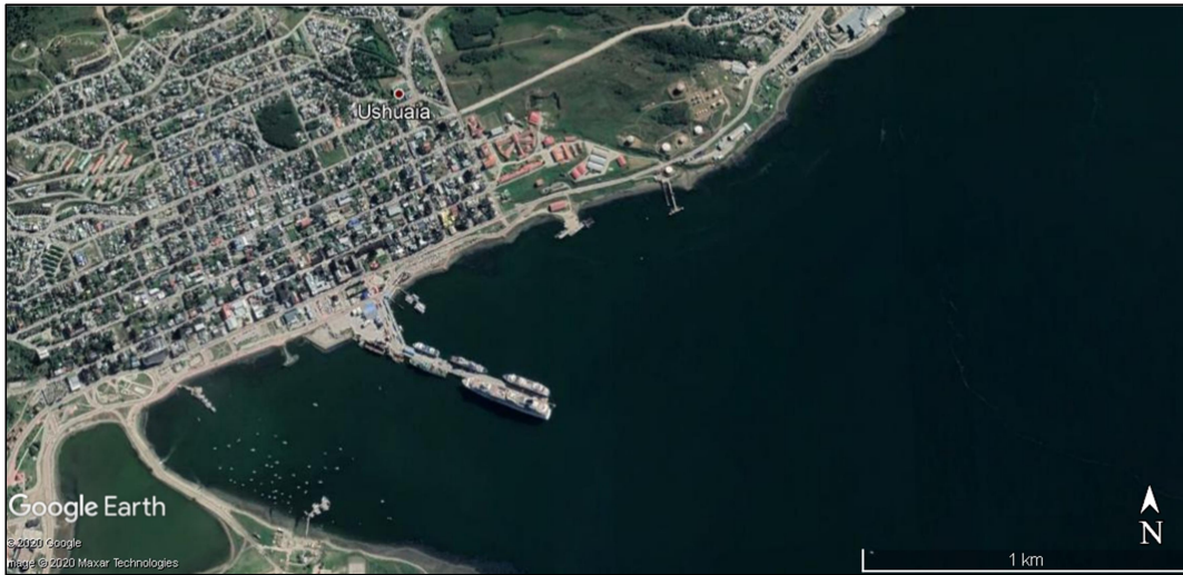
Foto 2 Fotografía satelital del Puerto de Ushuaia. Fuente: Google Earth.
