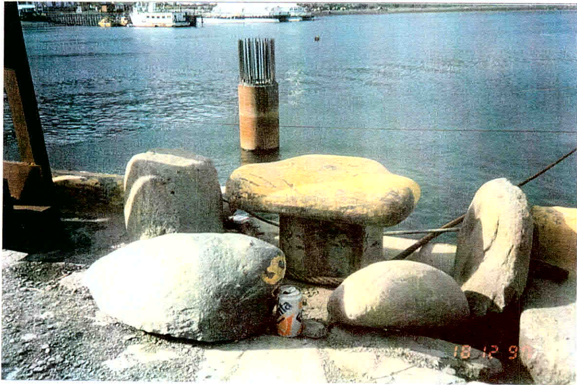
FOTO N° 1: BOCHONES DE ROCA EXTRAIDOS DURANTE LA EXCAVACION DE LOS PILOTES.
