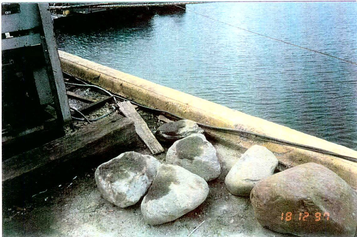
FOTO N° 3 : BOCHONES DE ROCA EXTRAIDOS DURANTE LA EXCAVACION DE LOS PILOTES.
